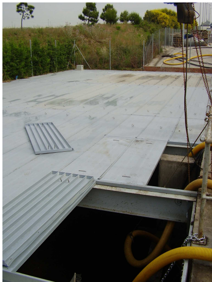
Cubrición desmontable con aspiración de gases hasta scrubber
