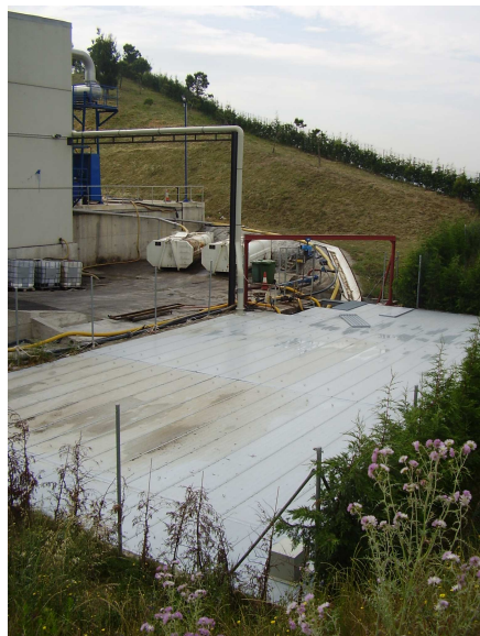
Cubrición desmontable con aspiración de gases hasta scrubber
